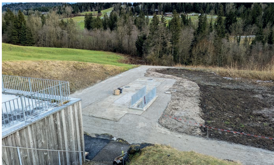
Betriebsgebäude und Pumpwerk Schlettern
